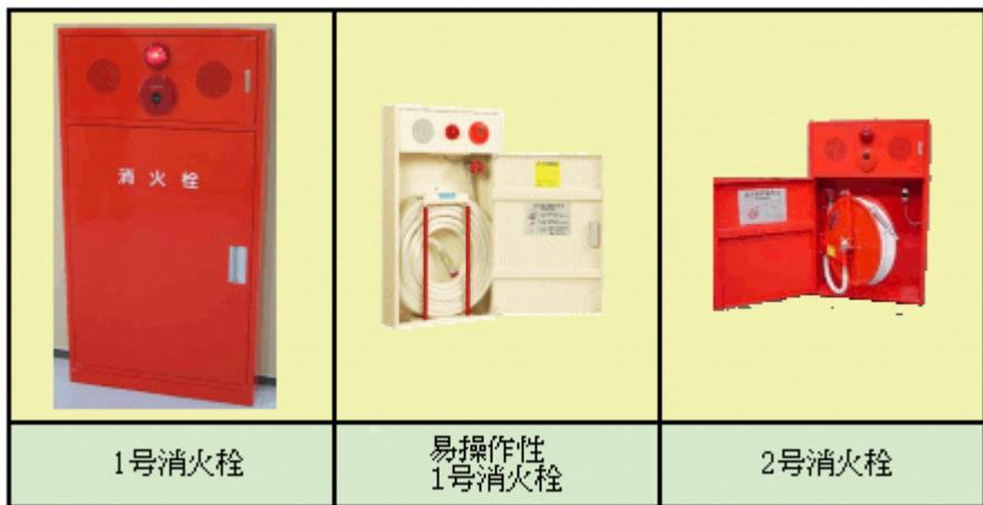
屋内消火栓には、2人で操作する1号消火栓と、1人で操作する易操作性1号消火栓と2号消火栓があります。
