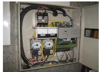
制御盤が故障するとポンプなどが作動せず断水するなど、日常生活に支障をきたします。
