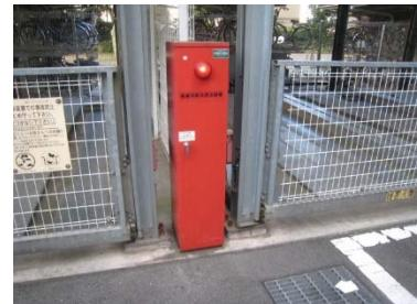
一般に、常時人が出入りする自走式駐車場では泡消火設備が使われるが多く、常時人がいない機械式駐車場などでは、不活性ガス消火設備等のガス系消火設備が使用されています。
