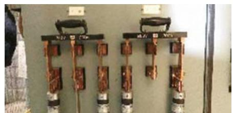
ヒューズ式ブレーカーのメンテナンスは、電気工事士による交換作業が必要です。また、交換ヒューズも入手困難な状況であり、復旧までに数ヶ月必要な場合も発生しています。現在は、ノーヒューズ式への移行が多いです。
