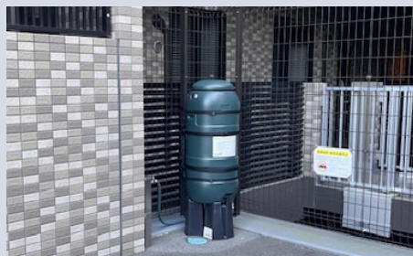
▲水栓付き雨水貯留タンク
