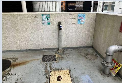
▲ 吸水に使用する散水柱
