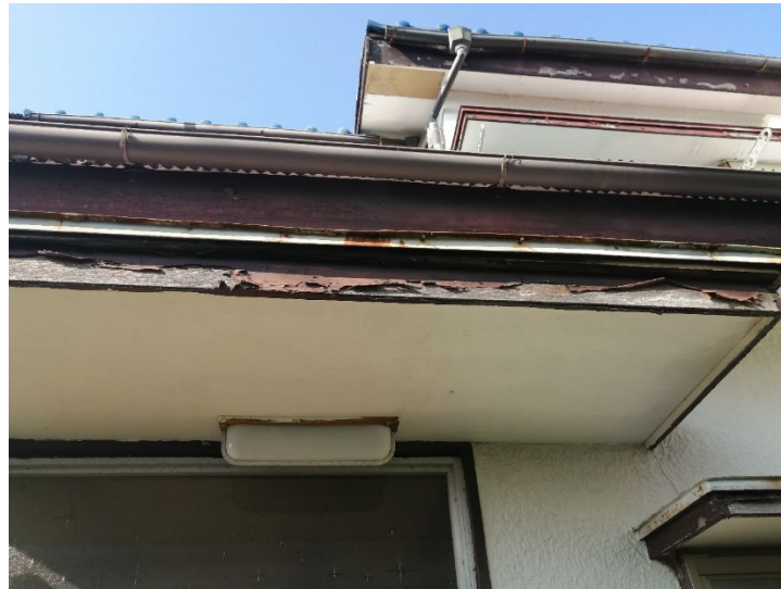
【軒天補修工事】
