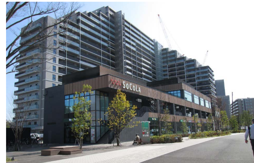
よこはま多世代・地域交流型住宅 (港北区箕輪町)
