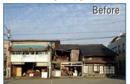
空き家の除却
