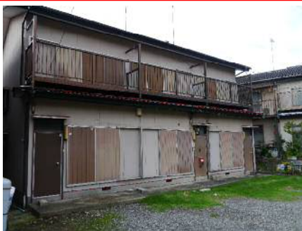
工事前の物件写真
