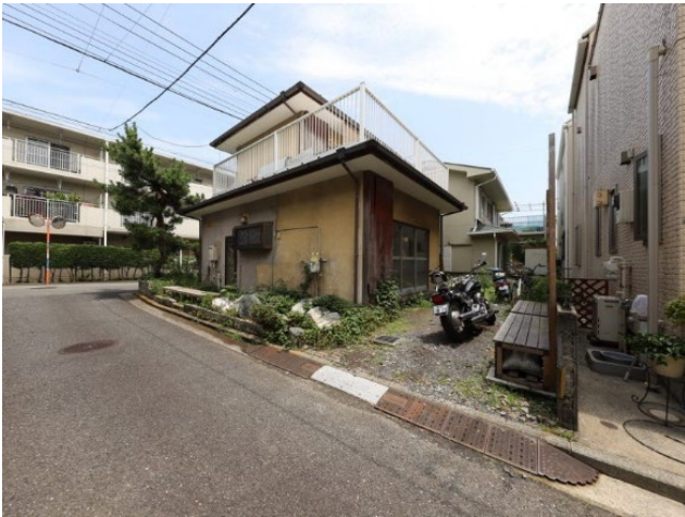
▲改修前の外観
