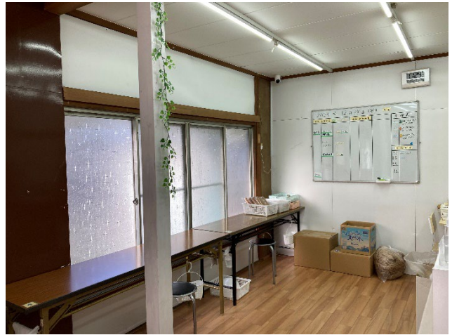
▲施設内作業場（間仕切壁と押入れを撤去）
