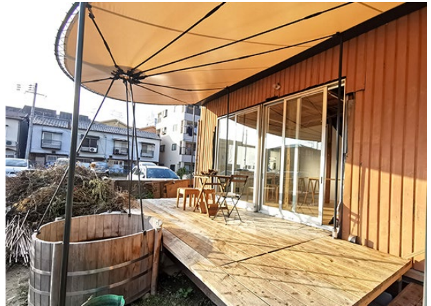
▲キッチンサロンのウッドデッキ縁側。檜風呂を活用した雨水タンク。野菜の水やりに活用
