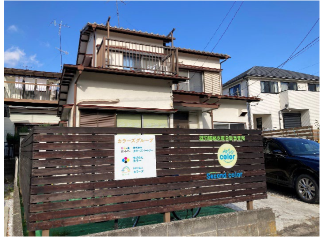
▲改修後の外観
