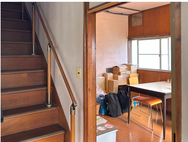
▲階段手すりの設置
