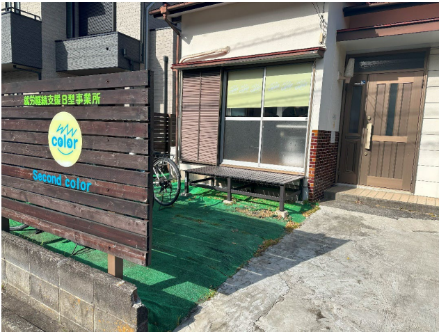
▲改修後、庭の整地と縁側設置の様子
