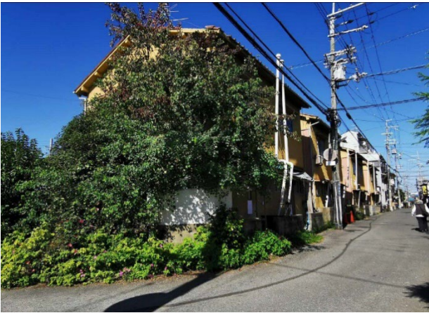
▲解体前の老朽木造長屋
