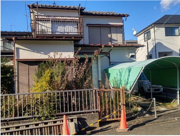
▲改修前の外観
