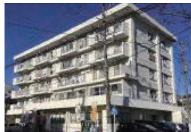
下之前住宅(南区)の建替え事例 建替え前
