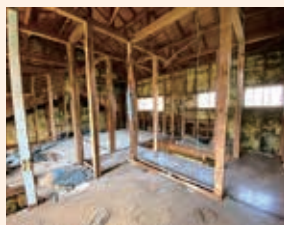
既存壁等解体
