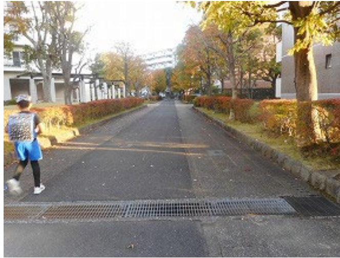
② 車道：アスファルト舗装 歩道：コンクリート版敷込
