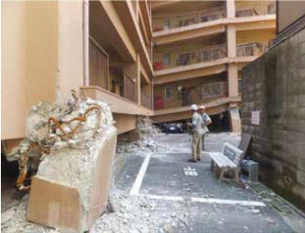
柱の座屈が起きて、ピロティ層が崩壊したマンション。
