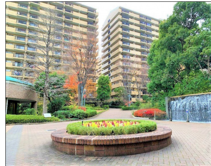
サン・ステージ緑園都市西の街 マンション外観
