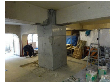
型枠を外したところ
