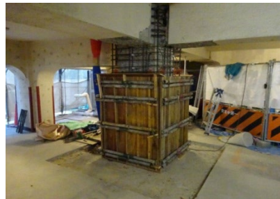
型枠をつけ、コンクリートを流し込みます
