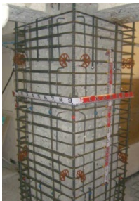
鉄筋を組んだところ
