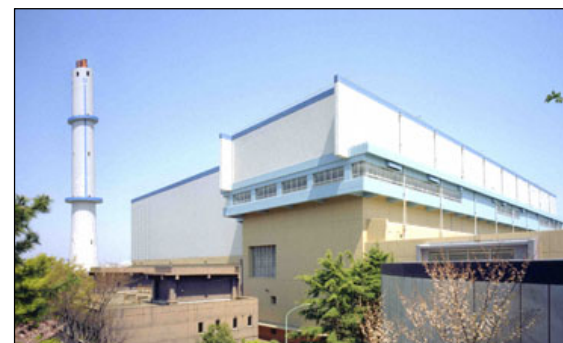
保土ヶ谷工場（昭和55年竣工）
