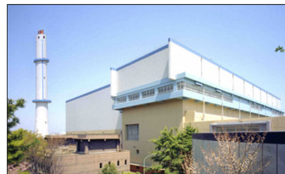
保土ヶ谷工場（昭和55年竣工）
