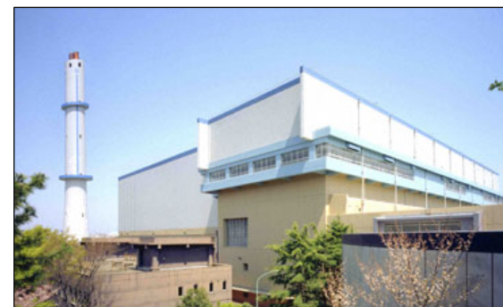
保土ヶ谷工場（昭和55年竣工）
