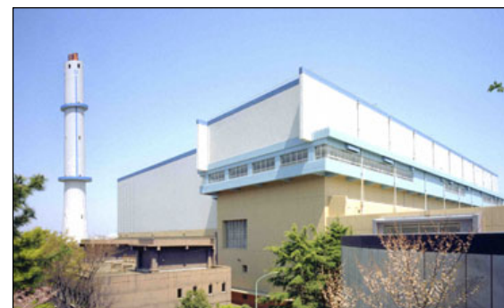
保土ヶ谷工場（昭和55年竣工）
