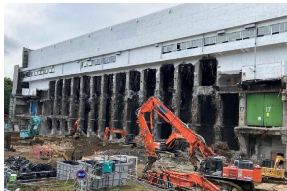
投入ステージ解体の様子（工場棟）
