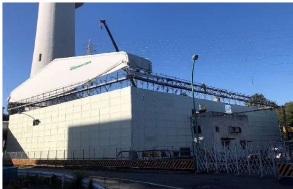
仮設テント設置の様子（排水処理棟）
