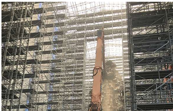
テント内での解体の様子（工場棟）
