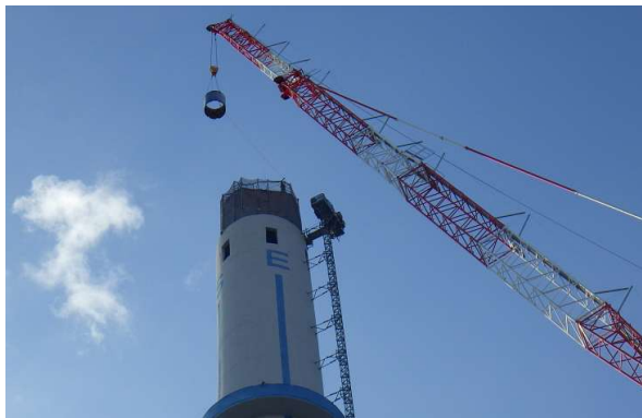
切断した内筒の吊り降ろしの様子
