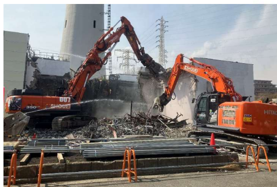
除染後の解体の様子（排水処理棟）
