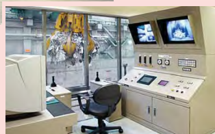
ごみクレーン操作室 Waste crane operating room
