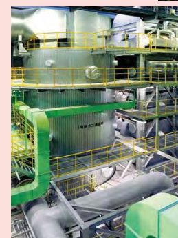
排ガス減温塔・エコノマイザ Exhaust gas cooling tower ・ Economizer
