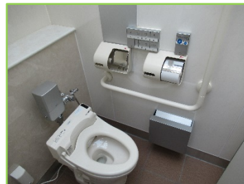
温水洗浄便座・荷物置き 西の橋公衆トイレ
