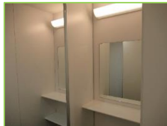
パウダーコーナー新設 桜木町駅前公衆トイレ
