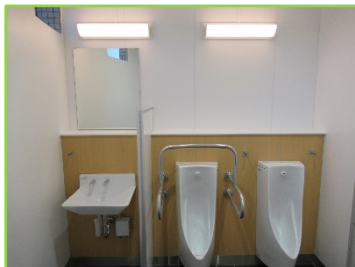
便器・手洗い更新、LED化 桜木町駅前公衆トイレ
