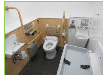
男女共用多目的トイレ新設 横浜アリーナ公衆トイレ
