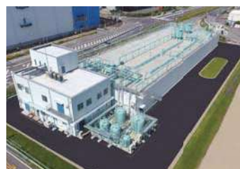
南本牧第5ブロック排水処理施設
