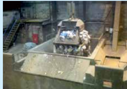
▲ごみクレーンで焼却炉にごみを入れる様子
