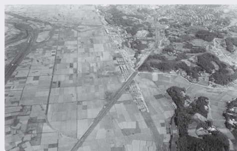
新幹線工事中 © 港北区役所
