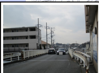
歩道の無い跨線橋
