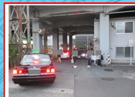
利用者が錯綜する道路
