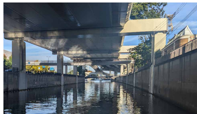
高速道路が架かる堀川 (元町・中華街栈橋(仮称)予定地付近から下流方向を見る)
