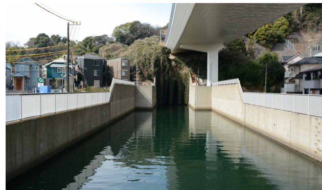
大岡川分水路(屏風ヶ浦橋から上流方向を見る)
