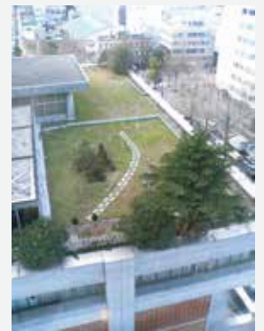
〈山下町(山下公園通り)〉 屋上緑化により空間に潤いを創出している例
