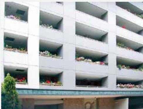
〈相生町3丁目〉 共同住宅の低層部のバルコニーにおいて草花による四季折々を演出している例 (落下防止などの安全対策を施してください)
