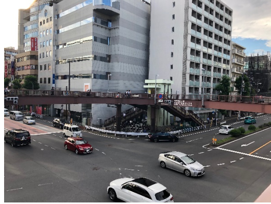
② 幹線道路(国道)を跨ぐ横断歩道橋
