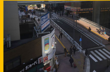
鶴屋橋の架替え
