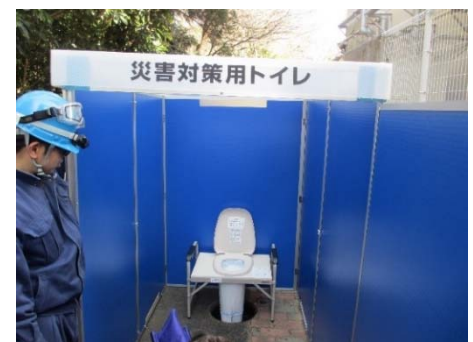
○HAMACOTOILET (山下小学校地域防災拠点)
