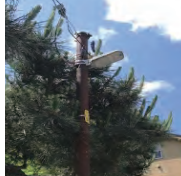
↑旧式の防犯灯の交換・増設
