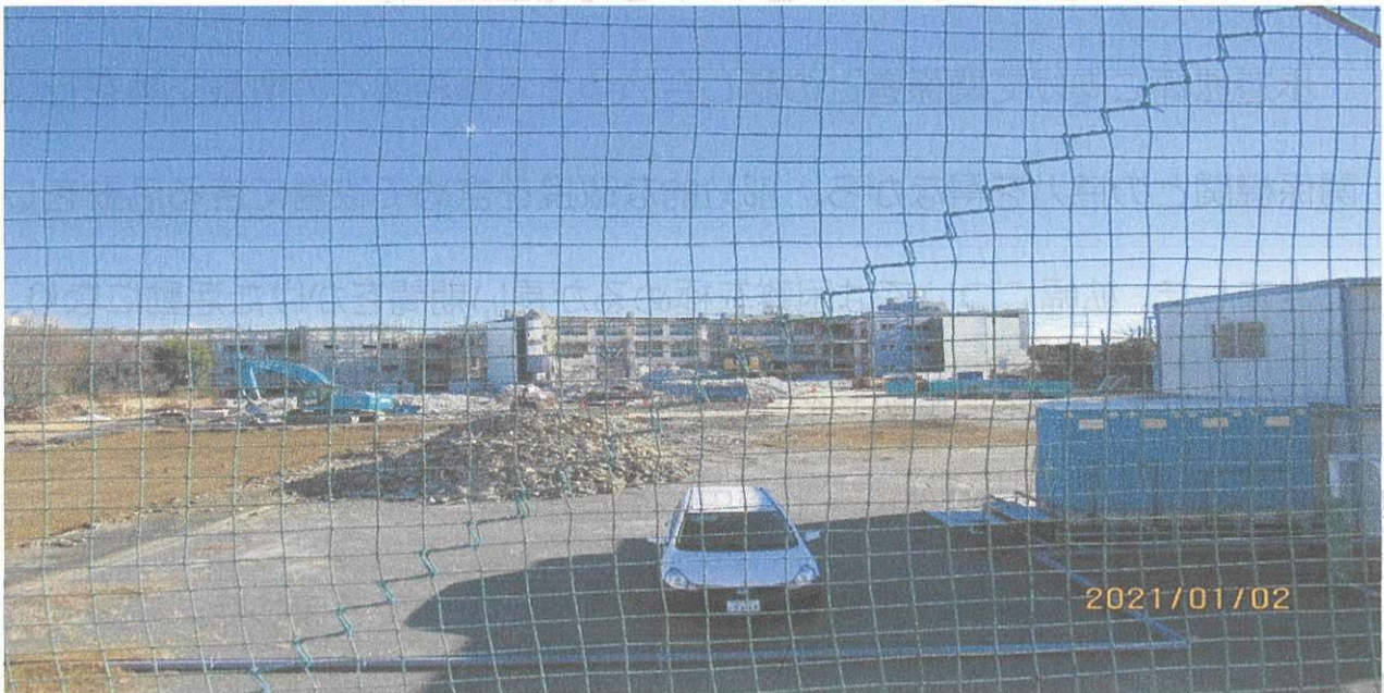
旧上菅田小学校解体工事現場（R3年1月現在）
