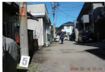
道路舗装整備前
