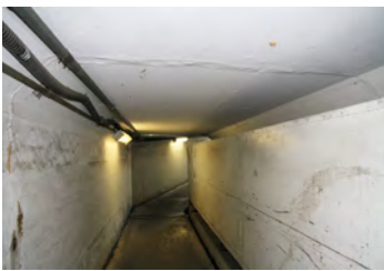
地下道の状況
