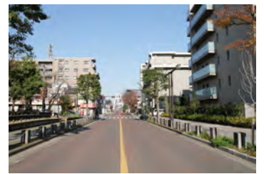
電柱地中化された町並み例
