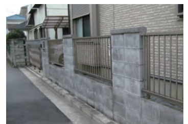
ブロック塀改善後
