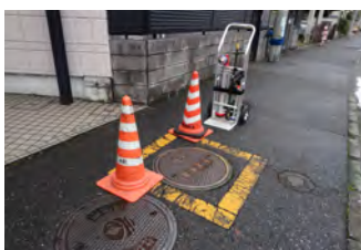
スタンドパイプを使った防災訓練
