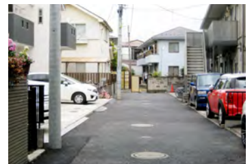
道路舗装整備後
