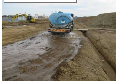
散水車による散水
