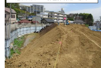
造成法面への粉塵抑制剤の散布
