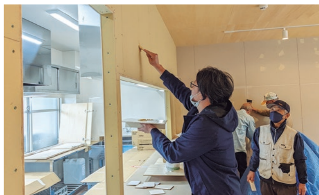
石膏ボードのバテ塗りや内壁塗装など、可能なところはシニアや地域の小学生も作業を担った
