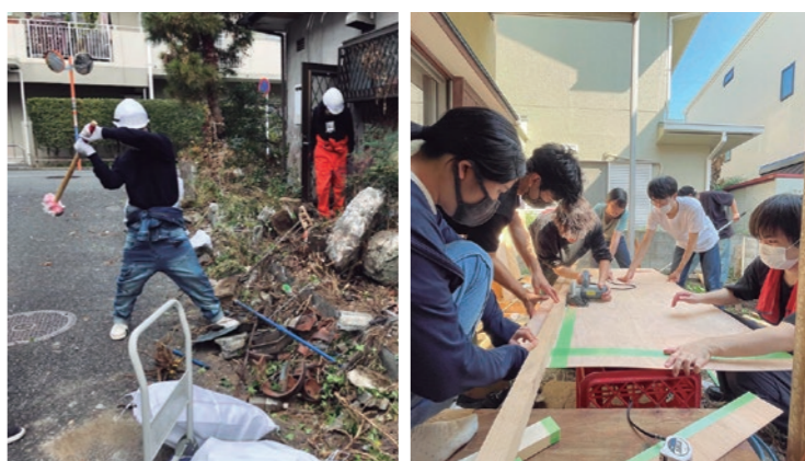
外構も含め建物の解体など、手掛けられる部分は住民の手で工事を行った
