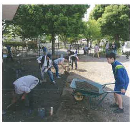
外構舗装には地域住民も参加して、土堀りやならしを行った。
