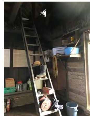
屋根裏に 上がる梯子
