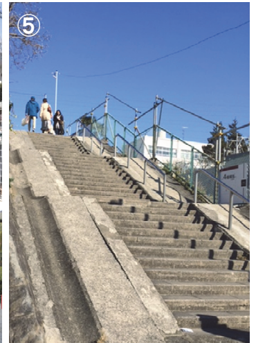
築後50年が経過し一部でコンクリートや舗装材の劣化もみられる
