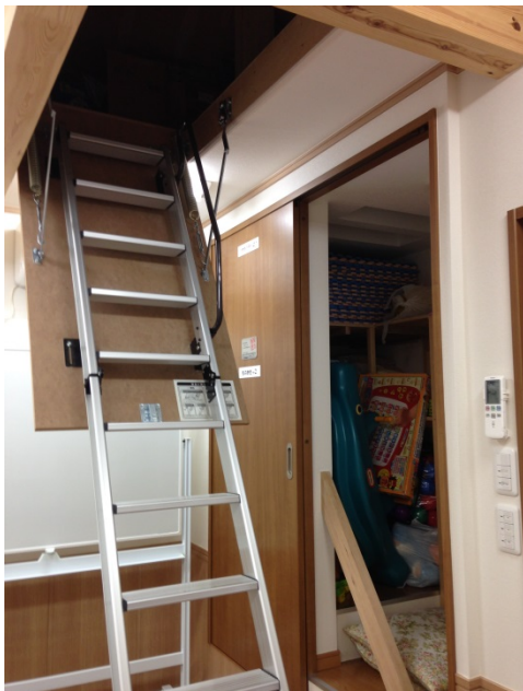
「まち普請事業」で整備した防災備蓄庫の様子
