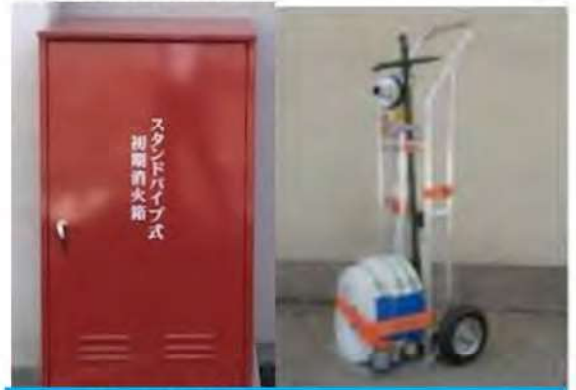
スタンドパイプ式 初期消火器具(可搬式)
