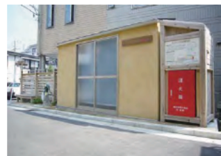
地下貯水槽と手押しポンプ
