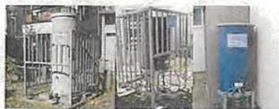
⑤ 雨水タンク設置
