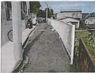
転落防止フェンスの設置
