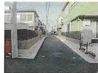
道路拡幅整備後
