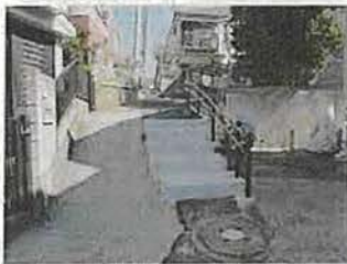
手すりの設置、階段補修（東台会）
