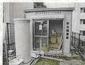
雨水タンク・防災倉庫（防災広場）
