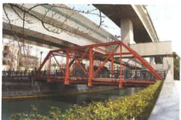
震災復興橋である浦舟水道橋（横浜市認定歴史的建造物）
