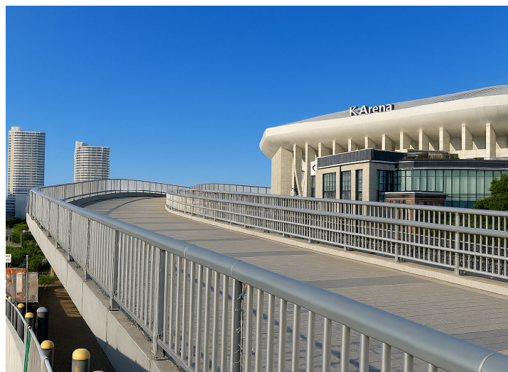
高島水際線デッキ（都市再生整備計画事業）
