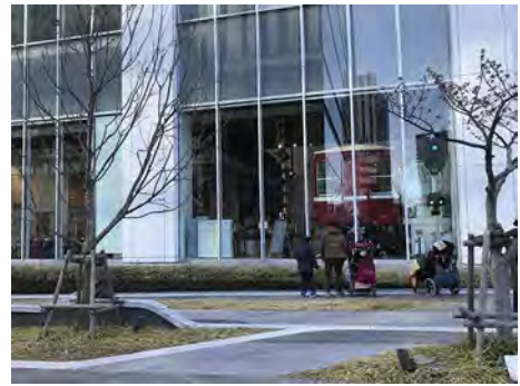
大型の開口部を設けることで、歩行空間のにぎわいを創出している例 (地区内)
