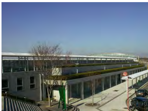
屋上緑化された駐輪場の例(石岡市)
