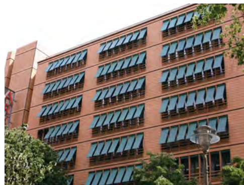
可動式ひさしによって大壁面を分節化している例(ベルリン)
