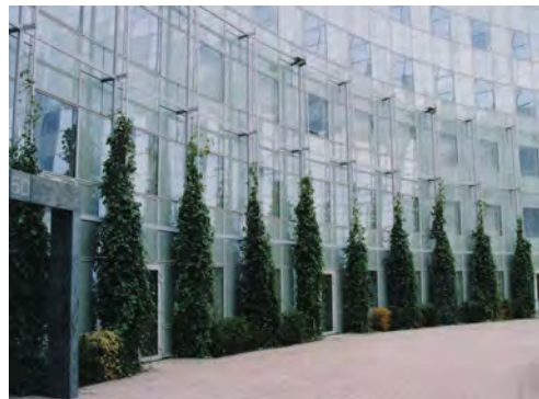
建物デザインと調和した軽快な素材の誘因施設によるカーテンウォールの緑化を施した例（パリ市）
