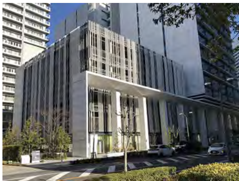
立体駐車場そのものを建物デザインに調和させた例 (地区内)
