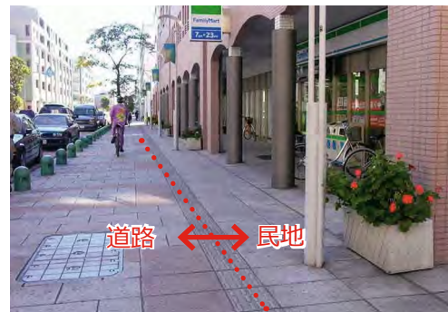
舗装素材やパターンを合わせ、見た目にも素材感や色調を揃えている例 (千葉市)
