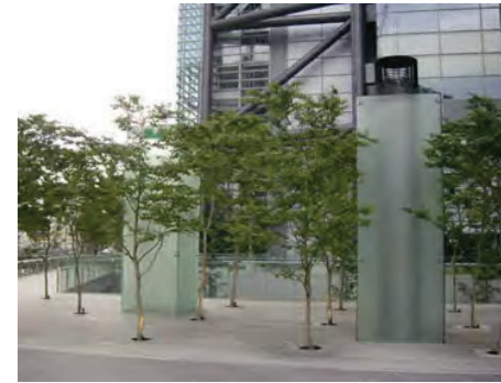
吸排気等を建物外壁と同様のガラスで修景した例 (港区)
