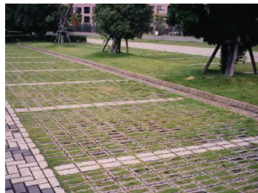
駐車区画を緑化ブロックや中木、ブロック舗装で修景している例（浦安市）
