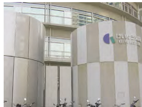
ガス設備等を建物と同様のデザインのオブジェやサイン内に組み込んでいる例 (地区内)
