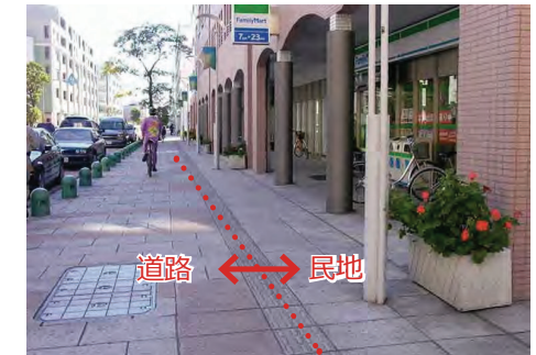
舗装素材やパターンを合わせ、見た目にも素材感や色調を揃えている例（千葉市）
