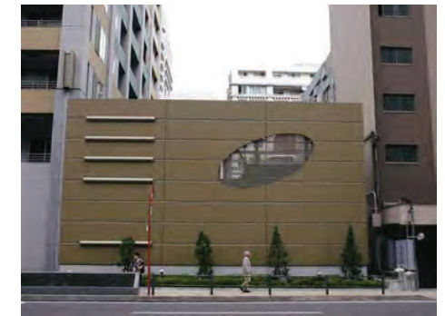
通りの連続性に配慮して立体駐車場外壁をデザインした例（関内地区）
