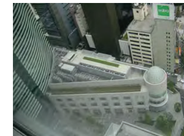
上方からの見え方にも配慮した設備類の修景の例 (港区)
