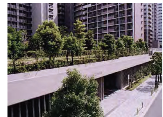
通りの連続性や緑の連続性をとぎれないように駐車場の出入口を設けた例（港区）
