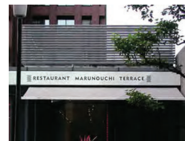
外壁デザインと合わせてルーバーで隠している例 (千代田区)
