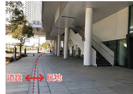
官民境界を目立たない同色系の舗装としている例（地区内）
