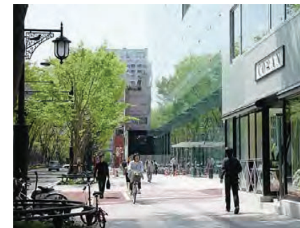
アクティビティフロアを通りに面して連続させることにより、屋内外相互の人の活動を「街のにぎわい」として感じられるようにしている例 (仙台市)
