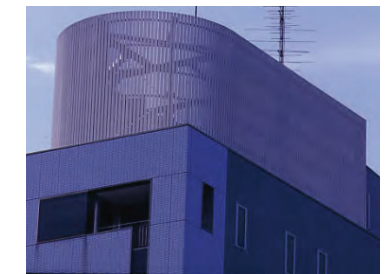
機器をルーバーにより隠している例 (文京区)
