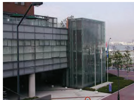
透過性素材によって軽快に仕上げつつ、美しく見える外階段デザインの例（新港地区内）
