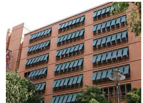
可動式ひさしによって大壁面を分節化している例(ベレリン)
