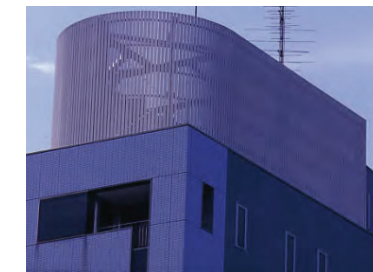
機器をルーバーにより隠している例（文京区）
