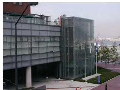
透過性素材によって軽快に仕上げつつ、美しく見せる外階段デザインの例 (新港地区内)
