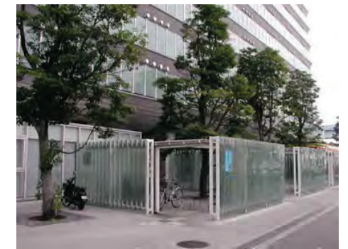
緑と半透過性素材によって軽快に仕上げている駐輪場の例(渋谷区)
