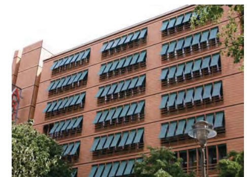
可動式ひさしによって大壁面を分節化している例(ペルリン)
