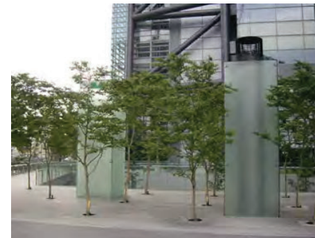
吸排気等を建物外壁と同様のガラスで修景した例 (港区)
