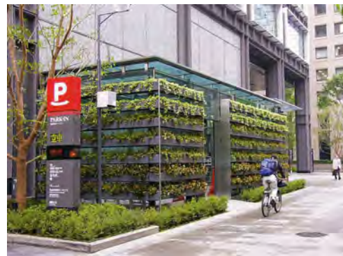
壁面緑化され景観に配慮された駐輪場の例(千代田区)
