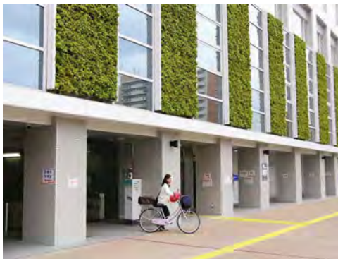
施設の内部（1階・地下）に自走式と機械式を組み合わせ取り込んでいる例(新浦安駅前)
