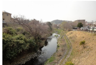
◆緑溢れる護岸が 周辺の自然景観と調和 しています (栄区尾月/いたち川)
