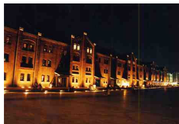
◆ランドマークとなっている施設をライトアップし、シンボル性を高めています (中区新港/赤レンガ倉庫)
