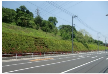
◆擁壁に植栽ブロックを用いることで 圧迫感や威圧感を軽減 するとともに、背後の 自然景観との調和 を図っています (東京都町田市)
