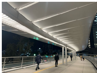
◆橋の構造を生かした照明により特徴的なデザインを際立たせ、ランドマーク性を演出しています (中区桜木町～本町／さくらみらい橋)
