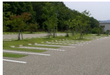
◆駐車場の舗装面を芝生で覆うことで、公園との一体感のある景観を形成しています (岐阜県各務原市/学びの森)
