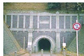
大原隧道 〈南区清水ヶ丘〉
