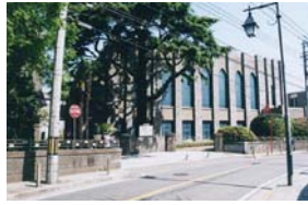
フェリス学院中学校・高等学校1号館 〈中区山手町〉
