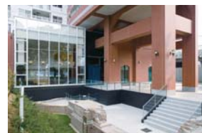
二代目横浜駅遺構(ロワール横浜レムナツ) <西区高島>
