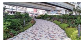
横浜北線及び岸谷生麦線高架下緑地～首都高高架下 からキリンビール横浜工場へと続く緑豊かな散策路～ (鶴見区生麦)
