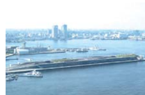
横浜港大さん橋国際客船ターミナル 〈中区海岸通〉
