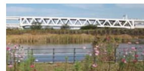
新横浜公園から見た大熊川トラス橋 (港北区新羽町(大熊川トラス橋) / 小机町(新横浜公園))
