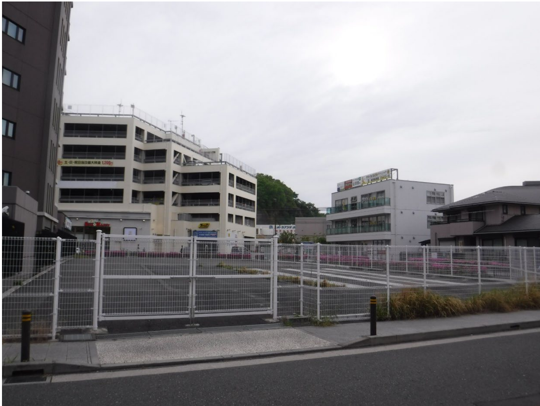
※北東側から撮影（令和5年4月19日時点）
