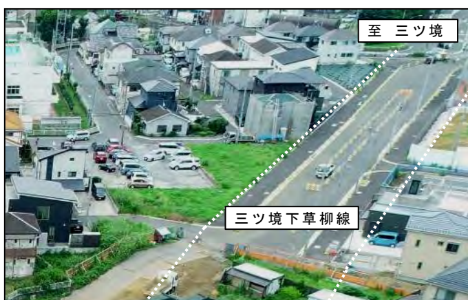
二ツ橋北部三ツ境下草柳線等沿道地区第1期地区 都市計画道路 三ツ境下草柳線(瀬谷区)
