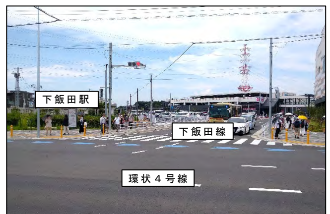
泉ゆめが丘地区 都市計画道路 環状4号線 及び 下飯田線(泉区)
