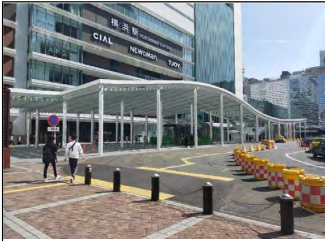
■横浜駅中央西口駅前広場：屋根
