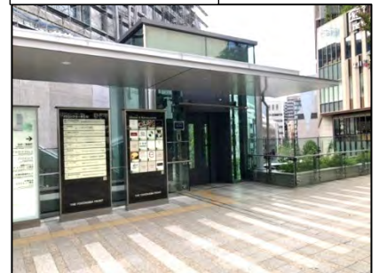
整備したエレベーター
